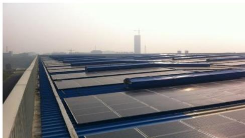
**3、光伏电站：**2015 年 2 月在换热管车间和南车棚建成的光伏电站共计装机容量 1.9 兆瓦，全年发电量可达 170 万千瓦时，每年相当节约 0.045 万吨标准煤，减排二氧化碳 0.16 万吨。
